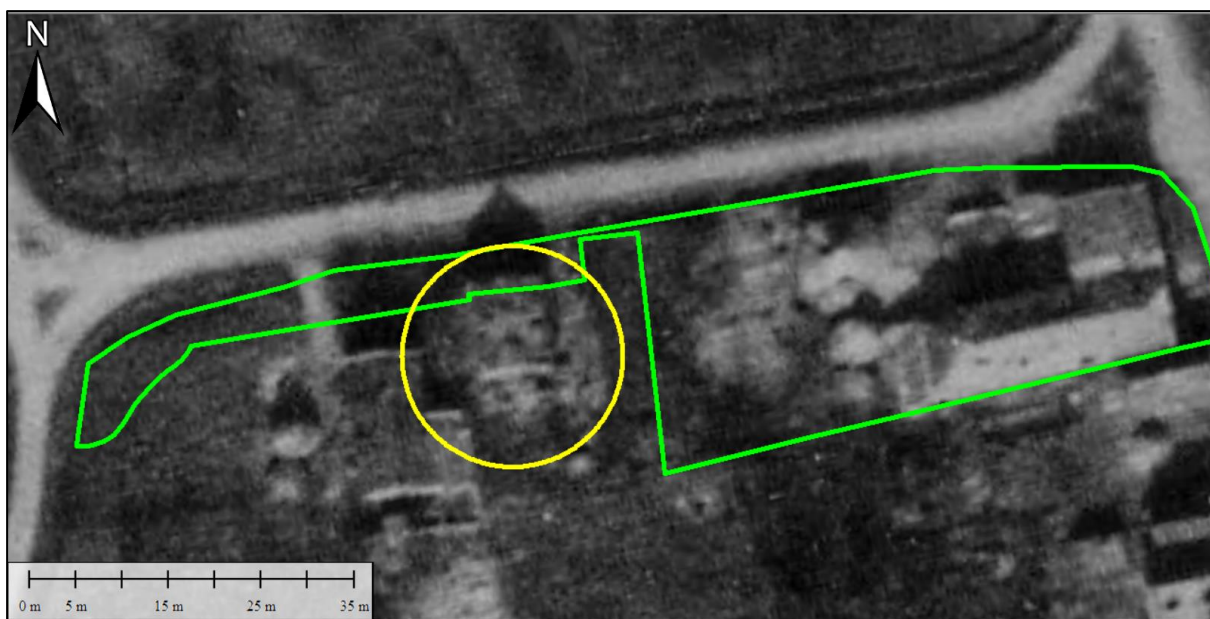
Figuur 4.7: Ingezoomde afbeelding van het beschadigde gebouw bij het projectgebied aan de Paterstraat.
