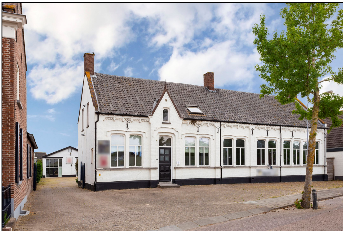
Afbeelding 3: Het voormalige schoolgebouw aan de Voorstraat.
