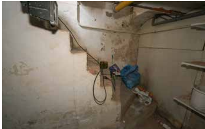
gemetselde trap kelder
