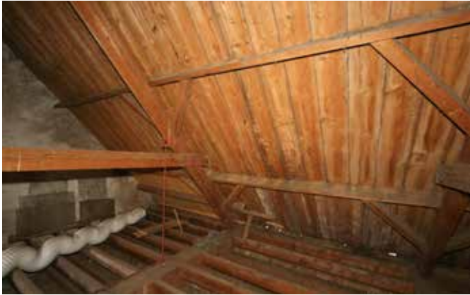
constructie met spantbeen, trekplaat, gordingen en schoren
