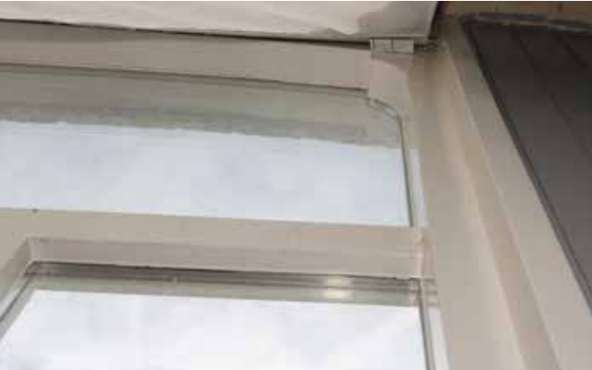
detail venster voorgevel
