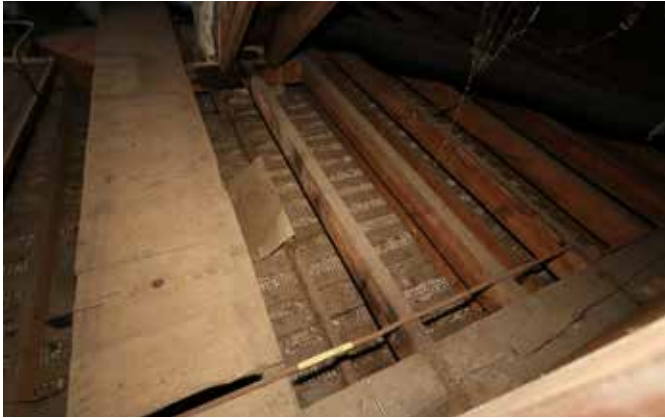
balklaag met daaronder stucplafond schoollokaal.
