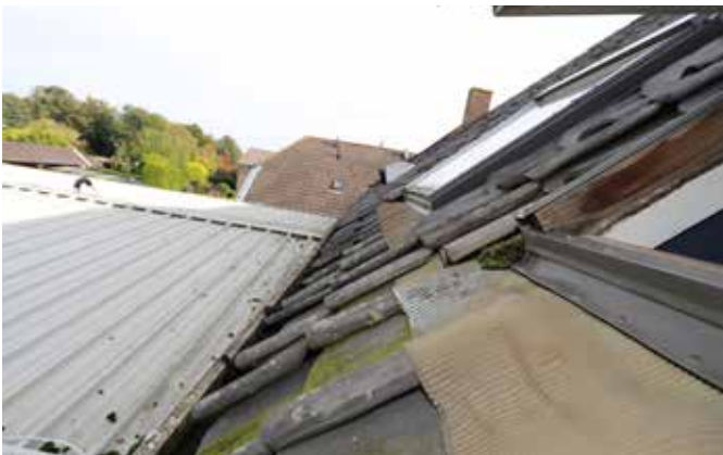
zicht op het dak, rechts de school
