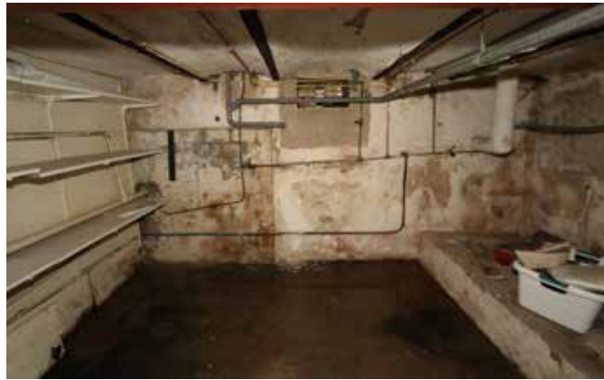
kelder richting achtergevel
