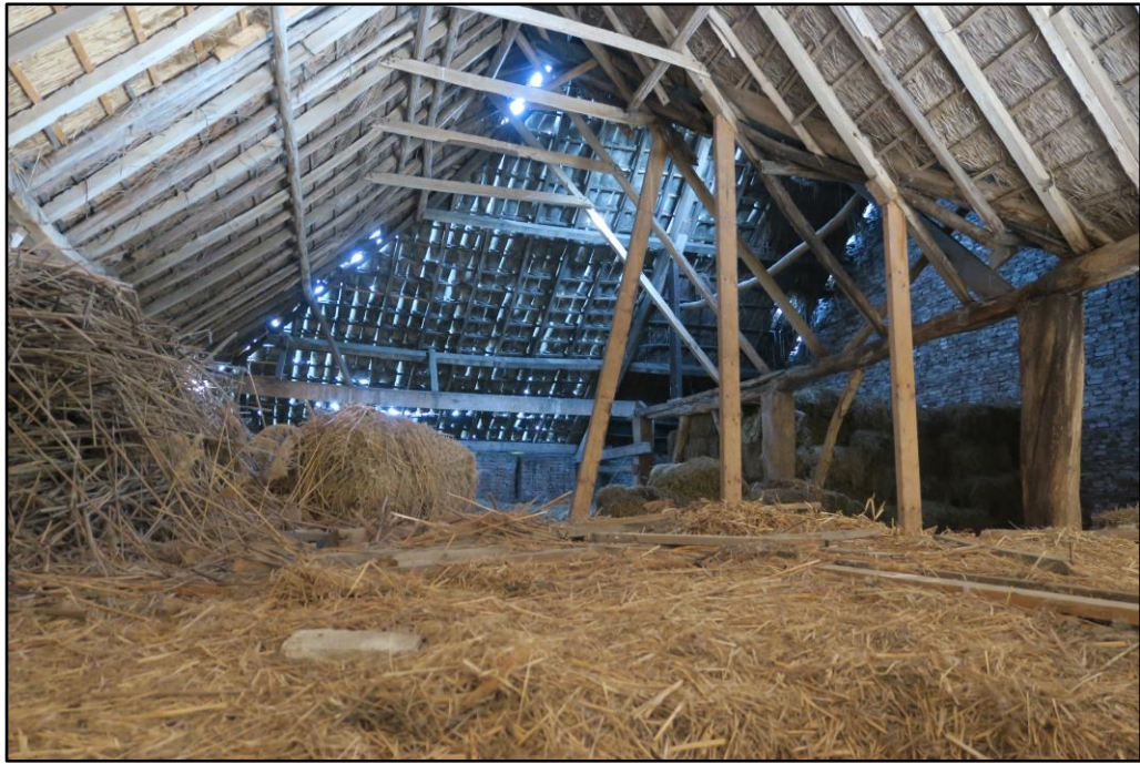
Figuur 3 Overzicht van de zolder van de schuur tegen het woonhuis.
