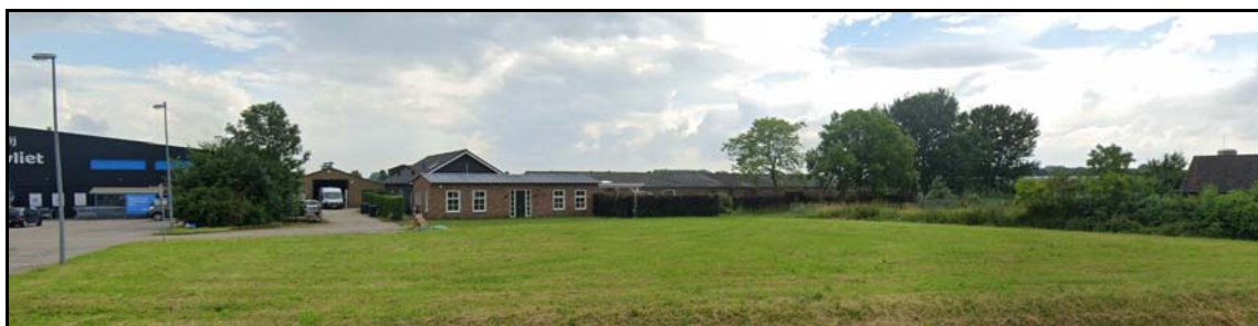
Afbeelding 5: Huidige bebouwing plangebied, met links nog een deel van het gebouw van de Hoogvliet.
