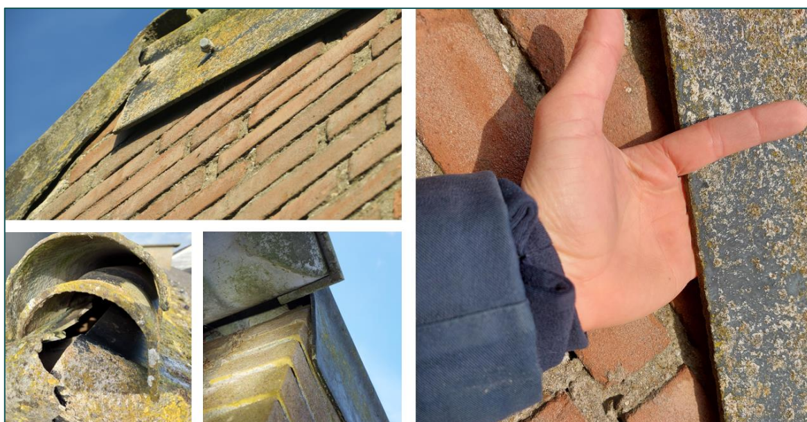
Figuur 3.3 In loods 1 en 2 zijn verschillende openingen aanwezig die geschikt zijn als invliegopening voor gebouwbewonende vleermuizen.
