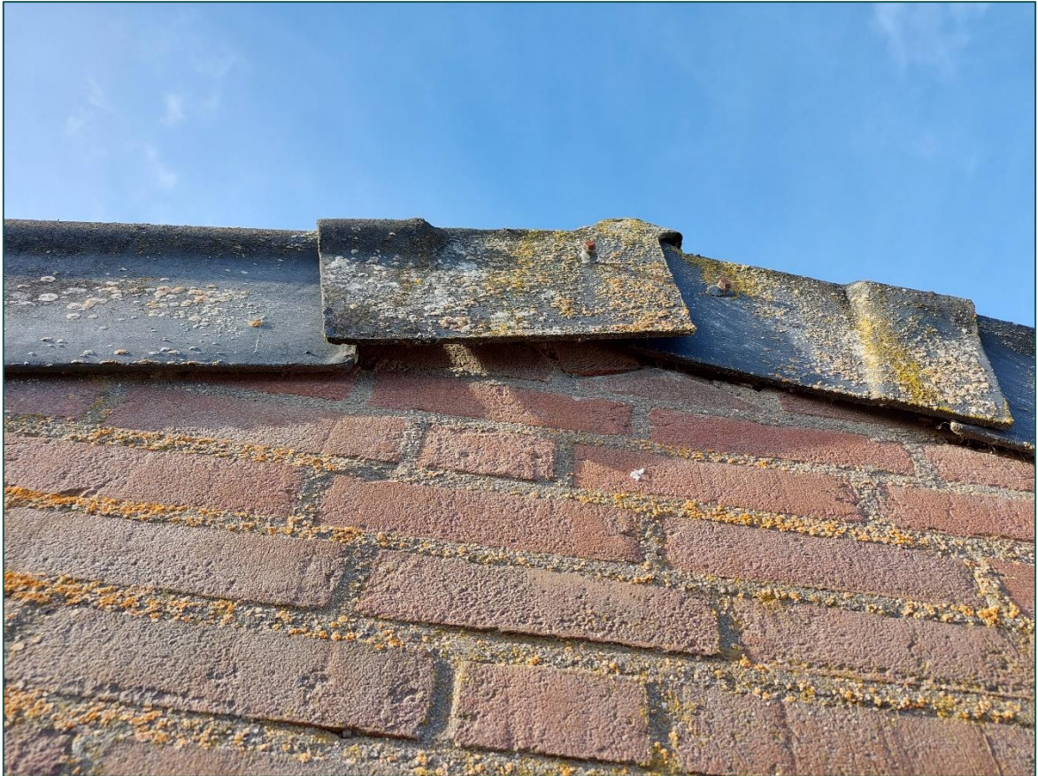
Figuur 3.1 In de het dak van de garageboxen is er voldoende ruimte aanwezig onder een windveer. Deze opening staat in verbinding met de spouw.
