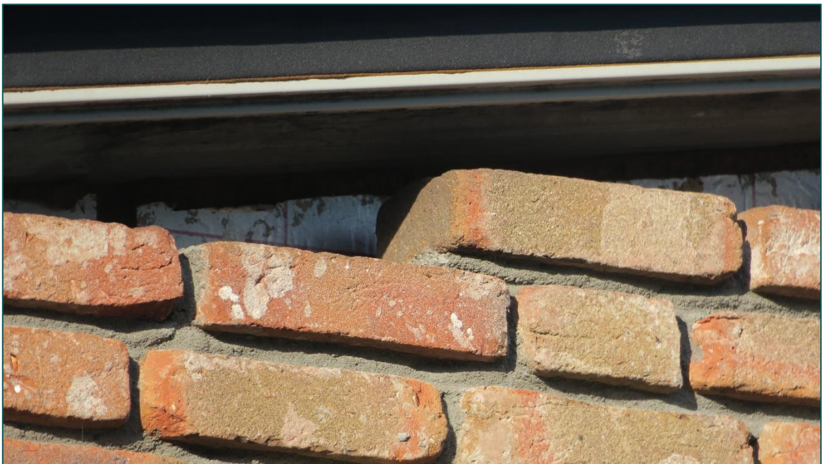
Figuur 3.2 De muren van de bedrijfswoning zijn open van boven en zijn volledig opgevuld met isolatiemateriaal.
