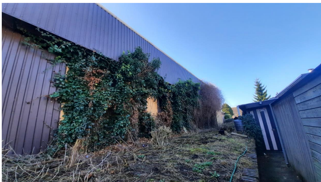
Achterzijde bedrijfsloods. Foto: B. Verhoeven | Ecoresult. B.V.
