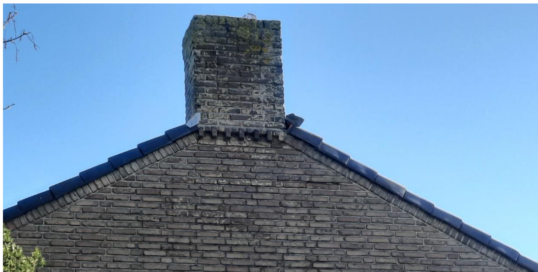
Figuur 9: Wijkende kantpannen en wijkend daklood kunnen toegang bieden tot potentiële nestplaatsen van huismus en gierzwaluw. Foto: B. Verhoeven | Ecoresult B.V.
