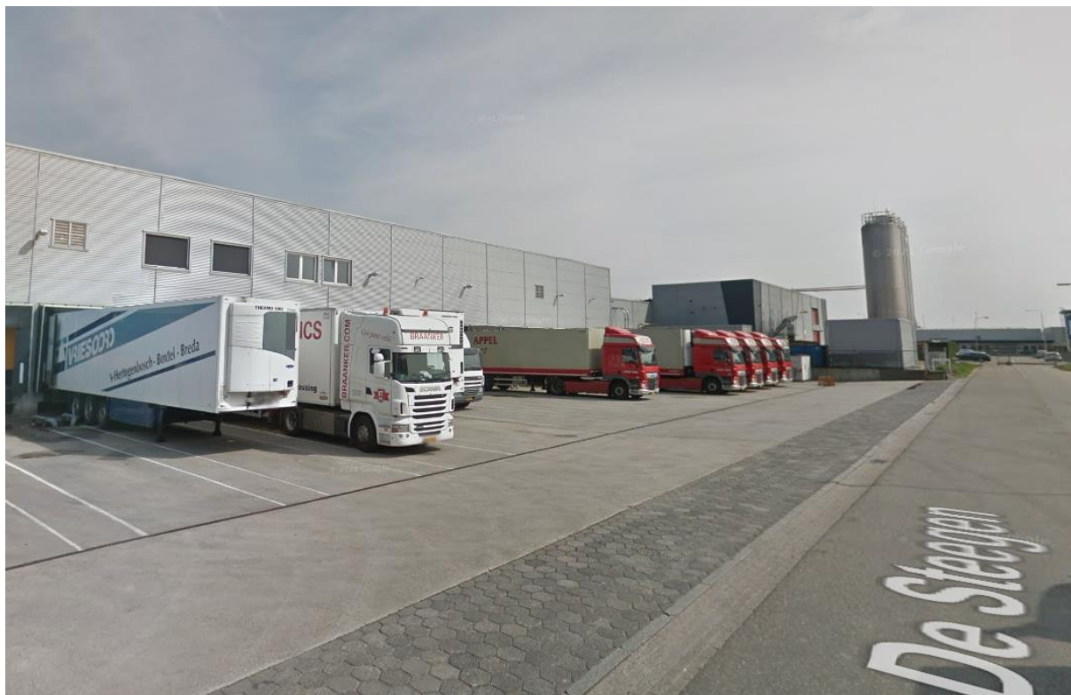
Figuur 4: Plangebied in bestaande situatie gezien vanaf de De Steegen (bron: google.com/maps)
