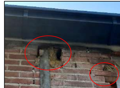
Figuur 22. Zicht op potentiële vleermuisverblijfplaatsen gemarkeerd met een rode cirkel in de woning (opstal 2).
