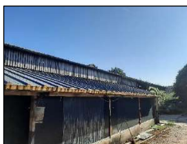
Figuur 14. Achterzijde van de koeienstal vanuit zuidelijke richting.
