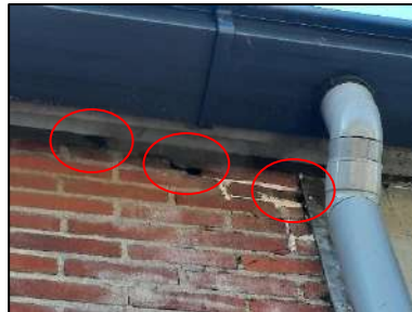
Figuur 21. Zicht op potentiële vleermuisverblijfplaatsen gemarkeerd met een rode cirkel in de woning (opstal 2).
