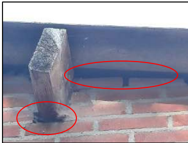
Figuur 20. Zicht op potentiële vleermuisverblijfplaatsen gemarkeerd met een rode cirkel in het schuurtje (opstal 4).
