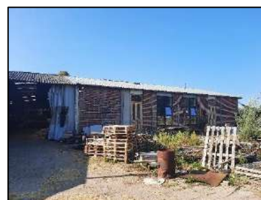
Figuur 9. Zicht op opstal 2 en aan de linkerzijde de ingang van opstal 3 vanuit noordelijke richting.
