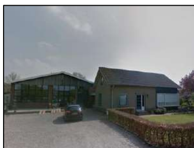
Figuur 7. Opstal 1 en opstal 2 vanuit westelijke richting.
