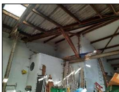
Figuur 13. Binnenzijde van opstal 3 vanuit zuidelijke richting.
