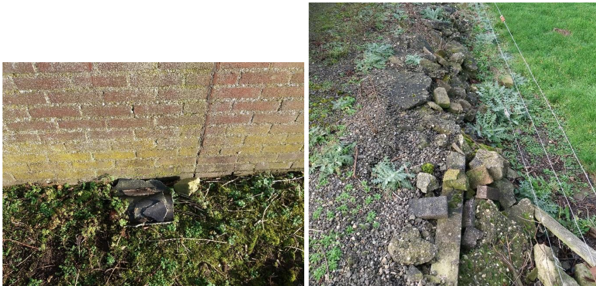
Afbeelding 3: Foto's veldinspectie achterzijde stal en detail ophoogmateriaal noordelijk nabij de perceelsgrens (zie locatietekening in bijlage 3)
