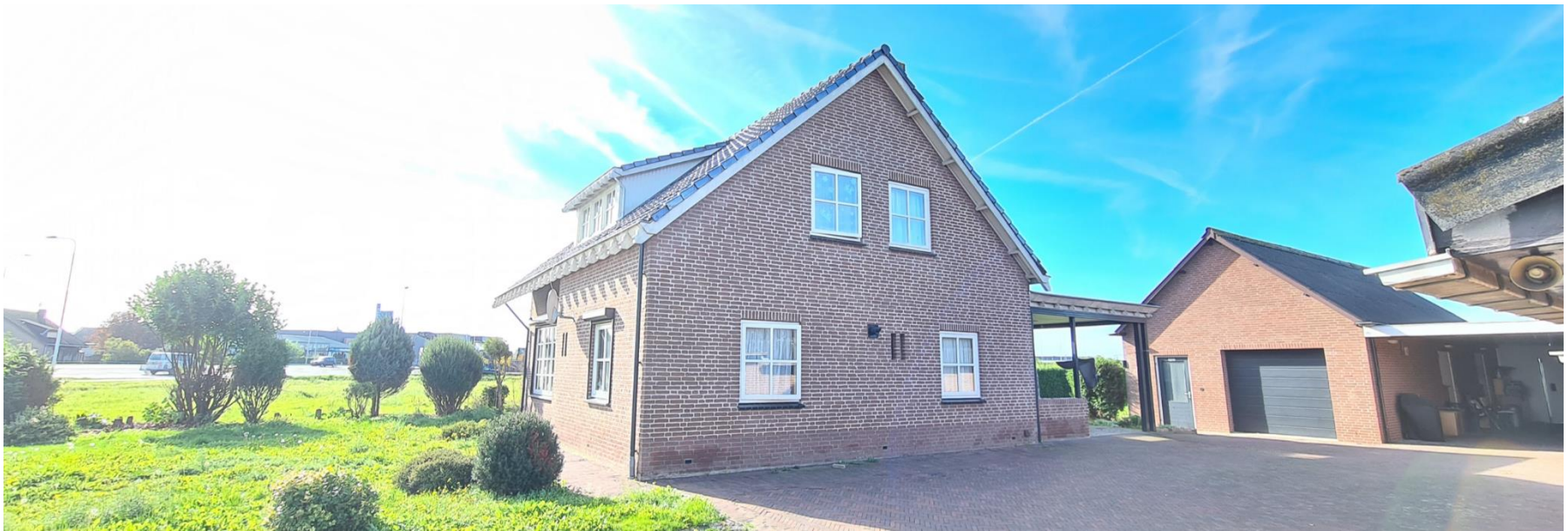
Figuur 4: Te slopen woning aan Provincialeweg 138
