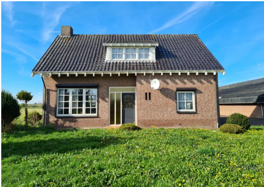
Figuur 6: Te slopen woning aan Provincialeweg 138
