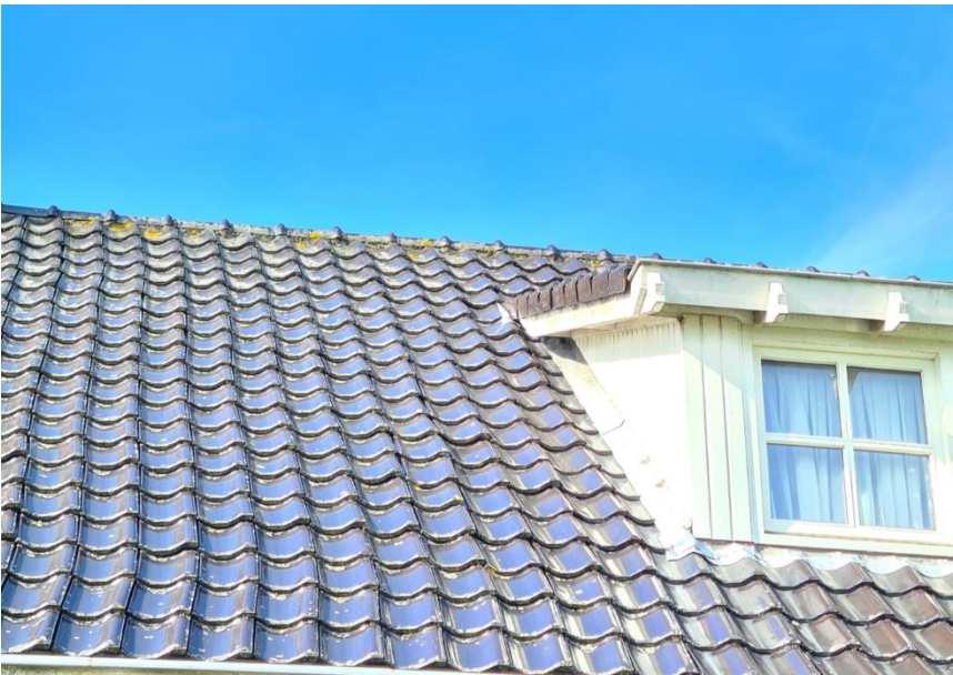
Figuur 8: Detail dak
