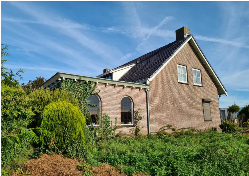
Figuur 7: Te slopen woning aan Provincialeweg 138
