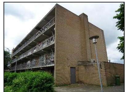
Figuur 8. Achterzijde zuidelijkst gelegen gebouw.
