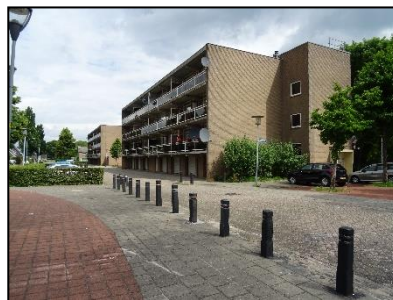
Figuur 4. Voorzijde middelst gelegen gebouw.
