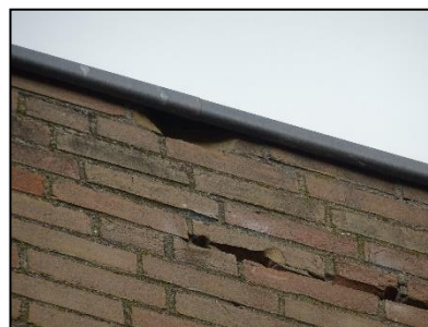
Figuur 13. Ruimte onder de dakrand waar vleermuizen gebruik van kunnen maken.
