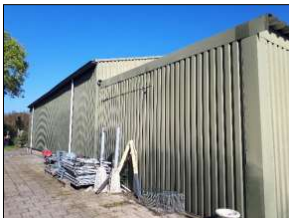
Figuur 7. Schuur bekleed met damwanden.
