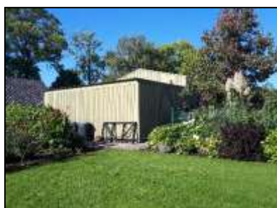
Figuur 3. Te slopen gedeelte schuur.
