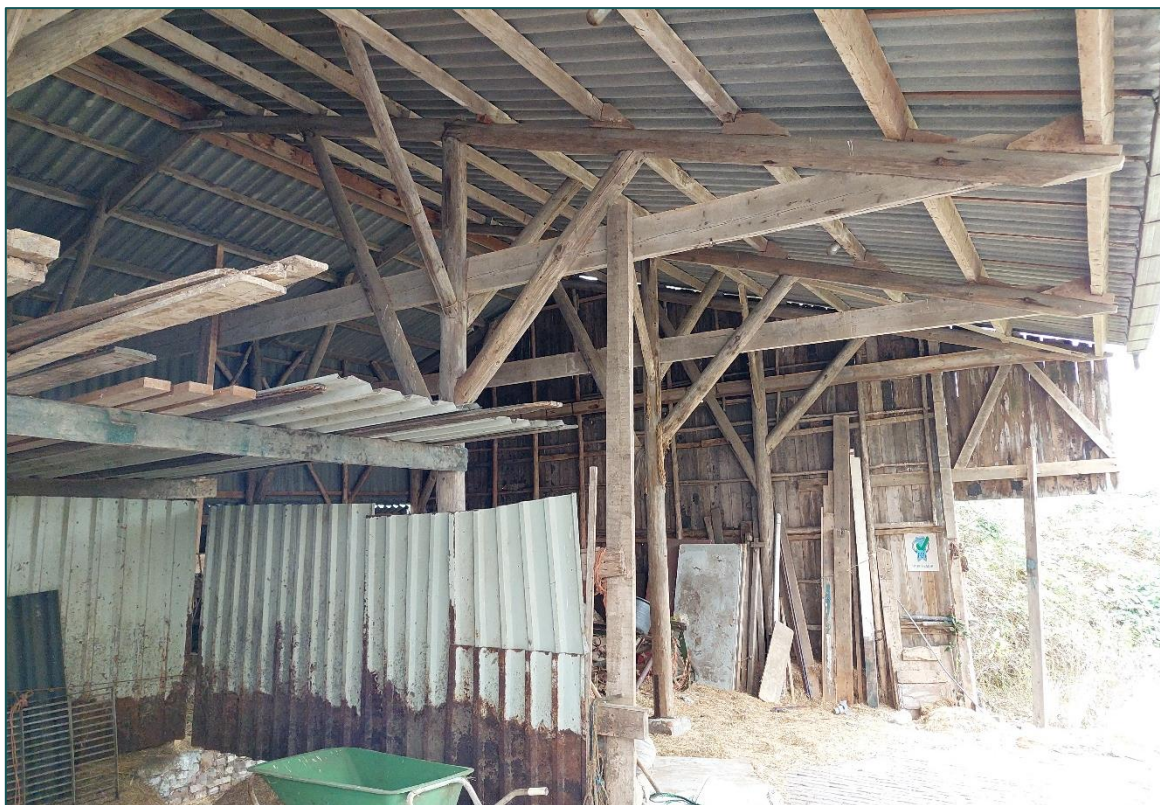
Figuur 2 De kapschuur (E).
