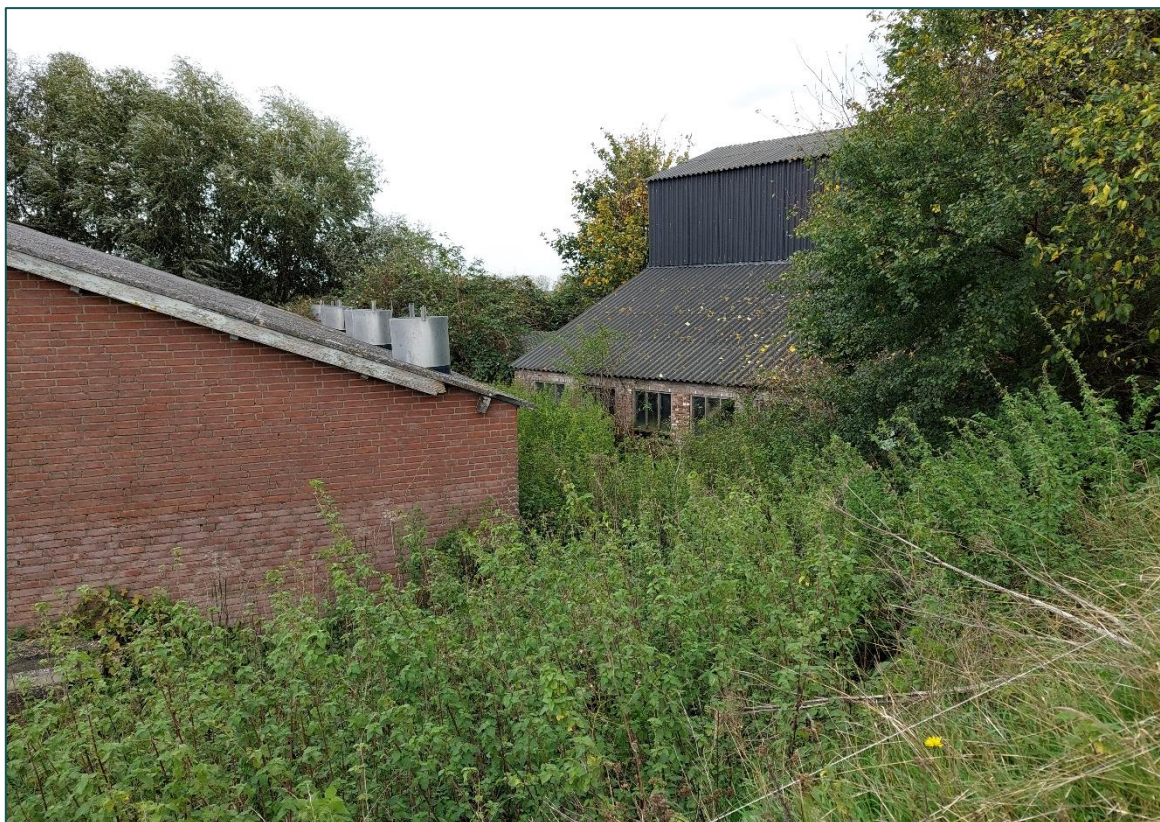
Figuur 6 De lage schuur (F) en stal G met tussendoor groen in de vorm van ruigtevegetatie.
