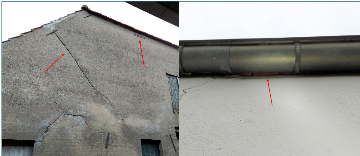
Figuur 3.1 In de woning en aangebouwde stal (A en B) zijn verschillende openingen aanwezig die leiden naar een spouw en/of dakruimte.
