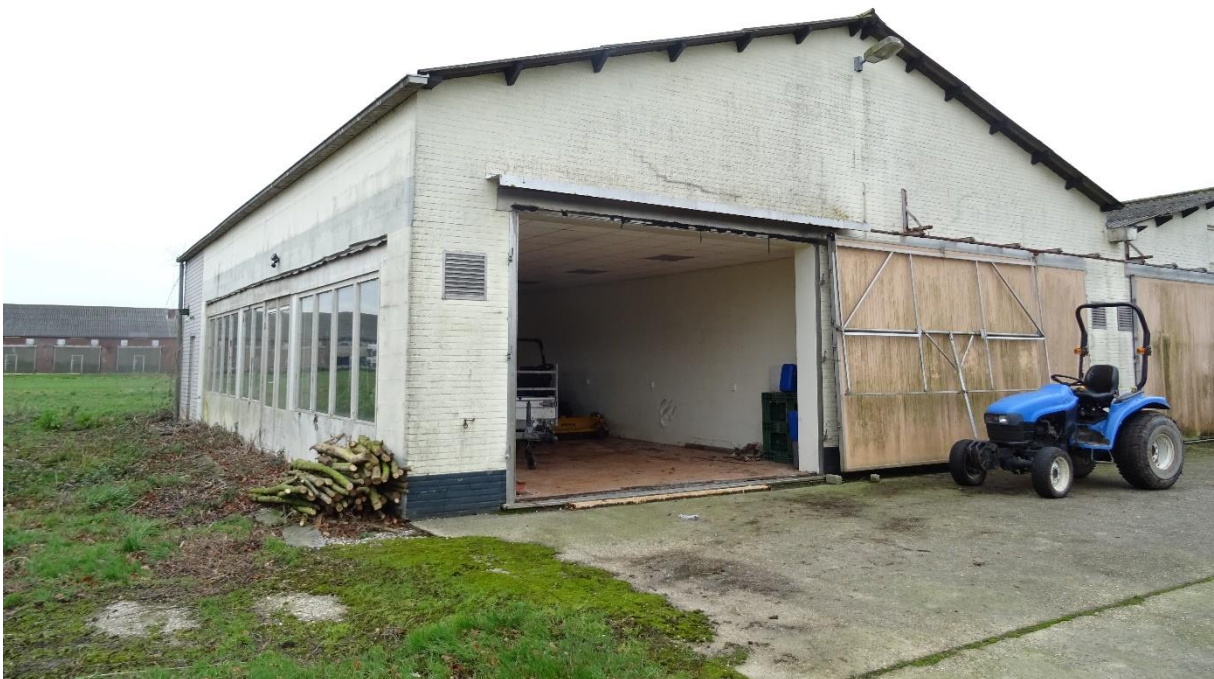
Afbeelding 5, 6 en 7: Bestaande te slopen voormalige champignonkwekerij. Bron: R.J.L. Bijvelds 29-03-2021 & 22-02-2022
