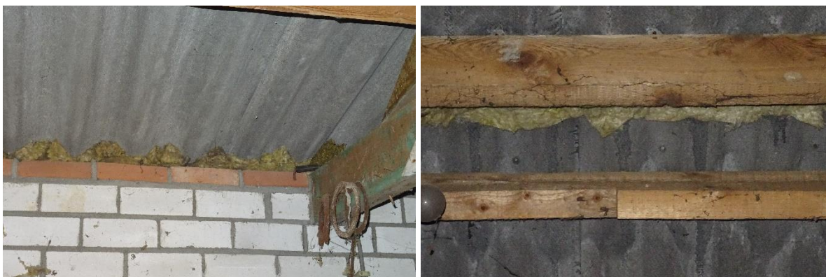
Afbeelding 27 en 28: afgedichte gaten en kieren in tussen golfplaten en muren en in de nok tussen balken en golfplaten. Mogelijk geschikte ruimten/ invliegopeningen zijn niet aangetroffen. Bron: R.J.L. Bijvelds 29-03-2021
