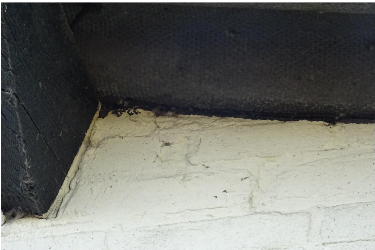
Afbeelding 24 t/m 26: afgedichte gaten en kieren in scheuren/ dilatatievoegen en daken zijn afgesloten met purschuim en kit. Bron: R.J.L. Bijvelds 29-03-2021 & 22-02-2022
