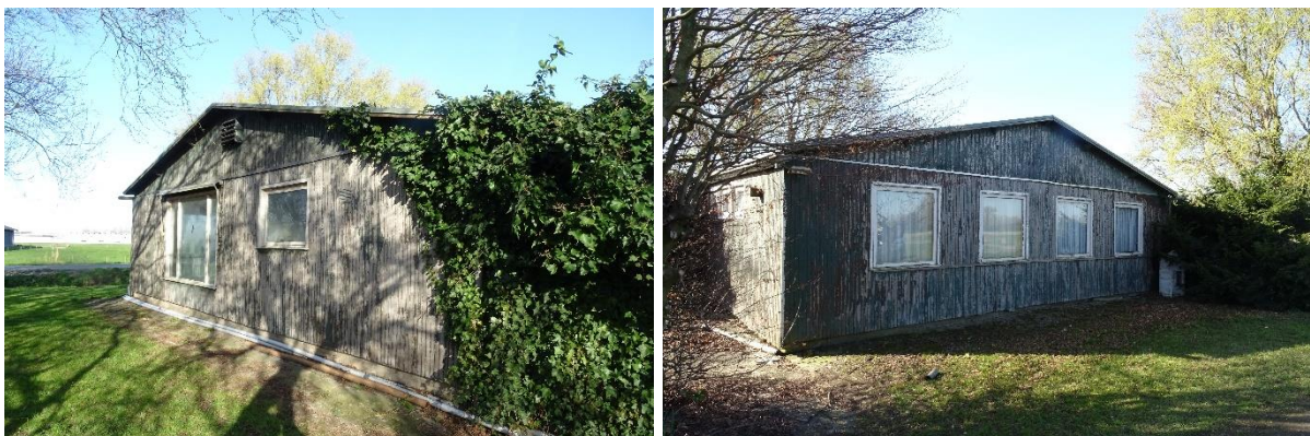
Afbeelding 3 en 4: Bestaande te slopen woning. Bron: R.J.L. Bijvelds 29-03-2021
