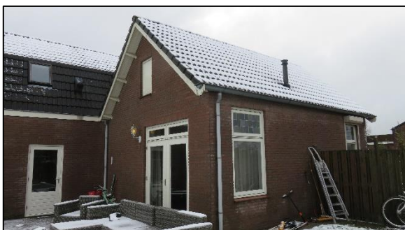
Foto 3. Achter- en zijgevel van het woonhuis
