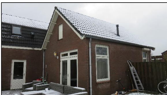
Foto 3. Achter- en zijgevel van het woonhuis
