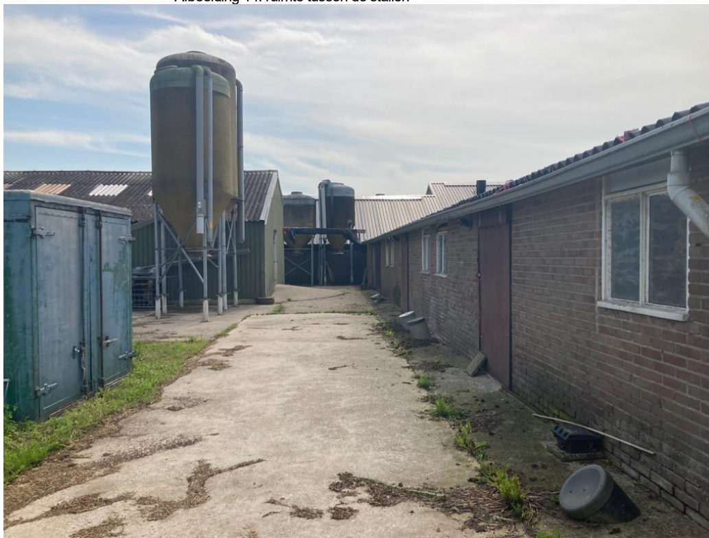
• Afbeelding 14: ruimte tussen de stallen
