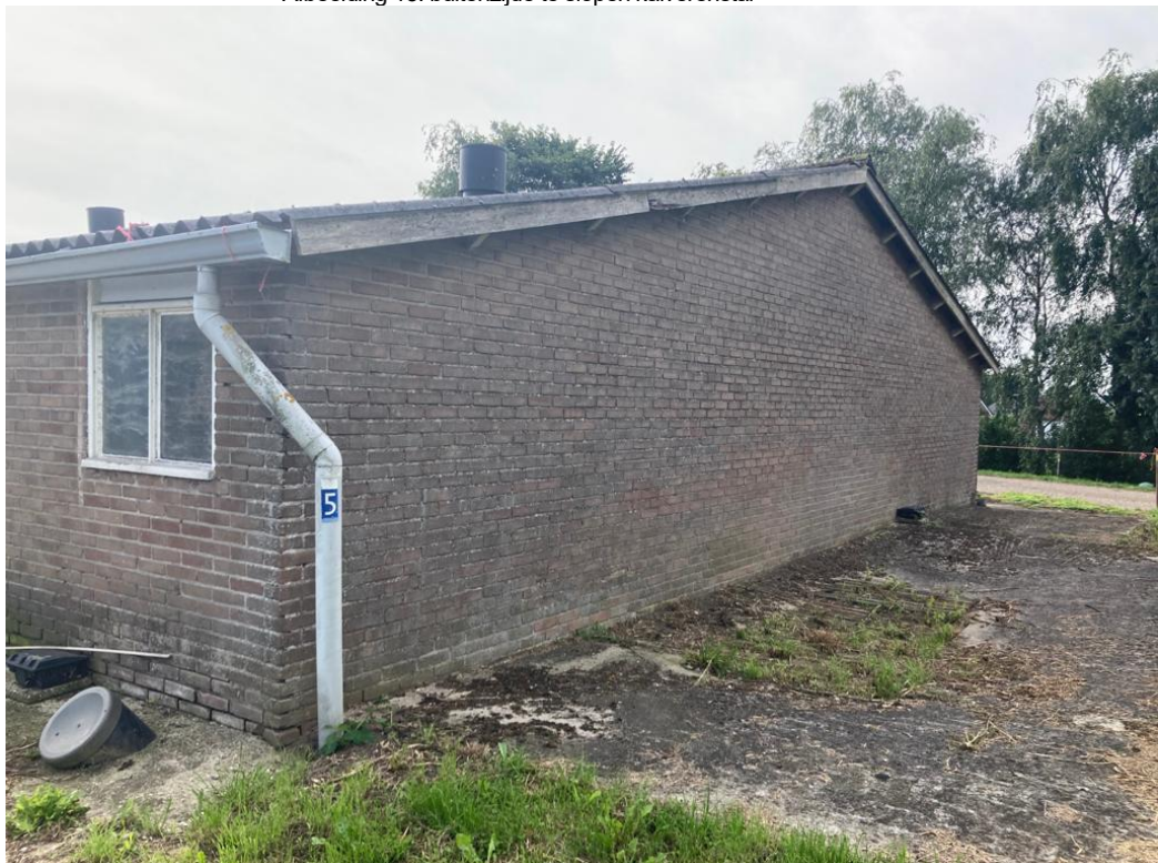
• Afbeelding 13: buitenzijde te slopen kalverenstal
