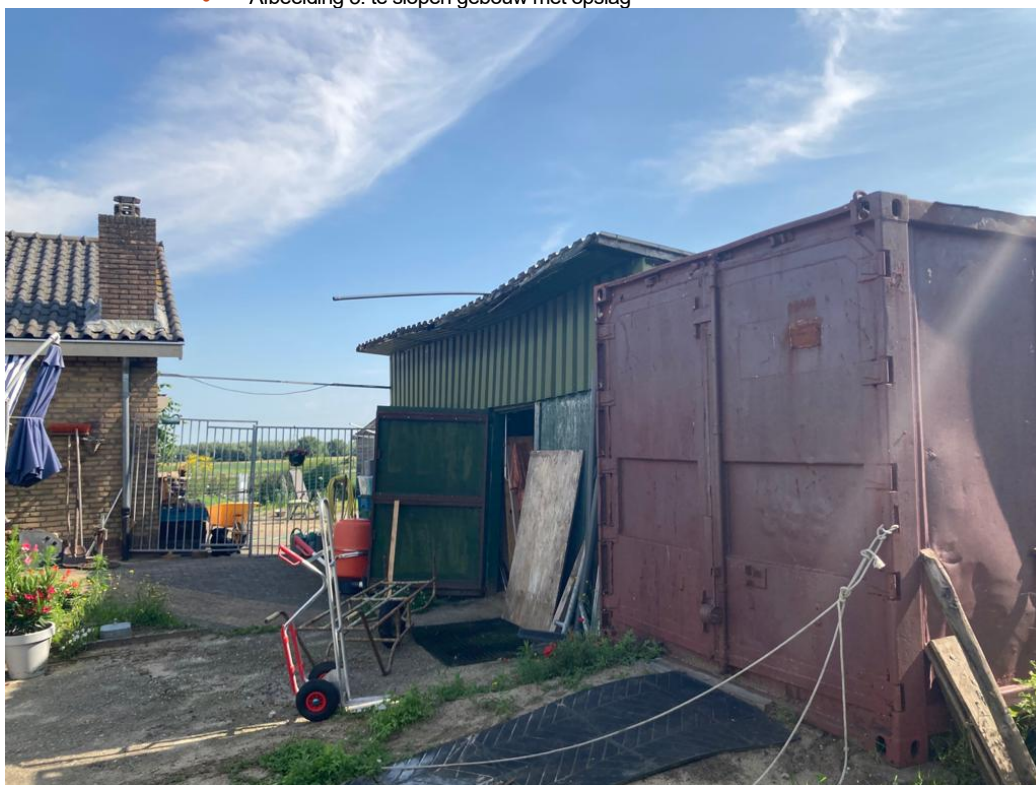
• Afbeelding 3: te slopen gebouw met opslag
