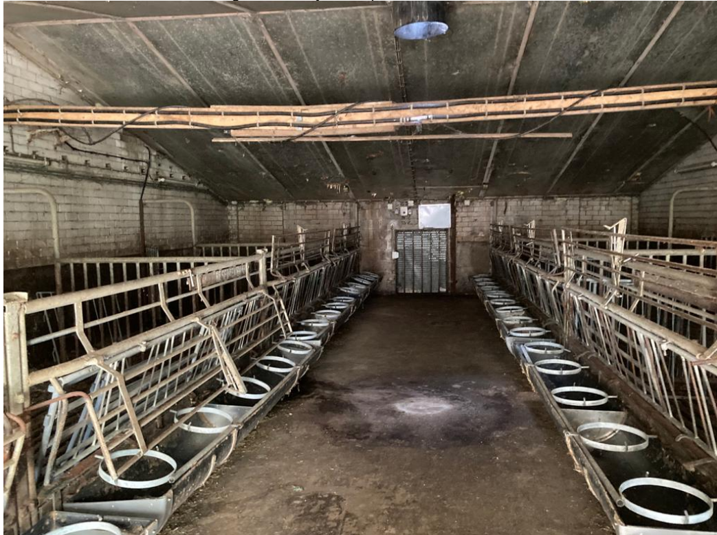
• Afbeelding 12: binnenzijde te slopen kalverenstal
