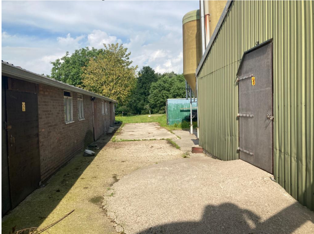
• Afbeelding 8: ruimte tussen de stallen
