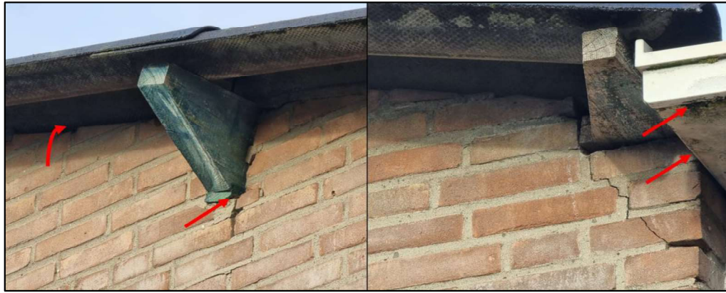
Figuur 4 Middels rode pijlen de openingen waar vleermuizen toegang tot de spouwruimte kunnen vinden.
