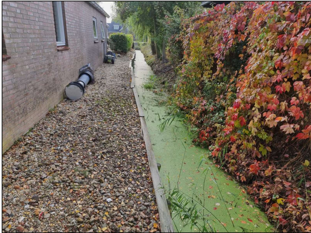
Figuur 5 De sloot aan de zuidwestelijke zijde van de planlocatie, volledig beschoeid aan de planlocatiezijde.
