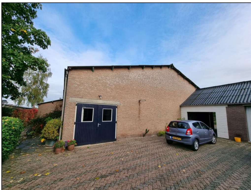
Figuur 2 De te saneren schuur is opgetrokken uit gemetselde muren met een golfplaten zadeldak.
