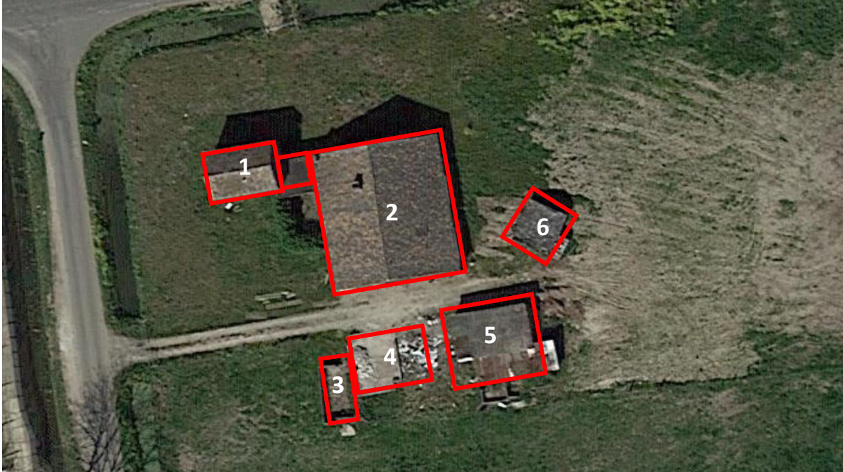
Overzicht te slopen gebouwen genummerd
