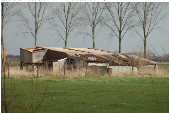
achteraanzicht varkens annex kippenstal (5)
