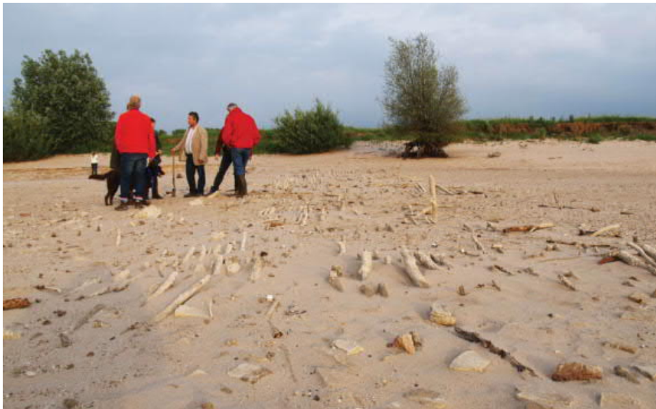
Foto 14.2 Spoor van houten palen markeert de contouren van de oude Tielsche Krib.
