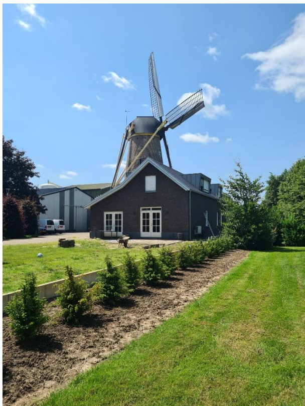
Zicht op de woning van de molenaar na verbouwing en na kap van (iig) boom 3
