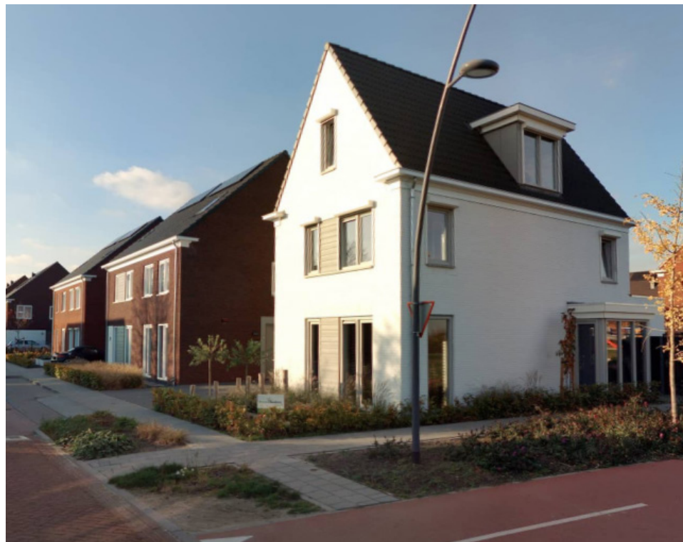
Mogelijkheid om vrijstaande woning uit te voeren in volledig wit metselwerk: 'special'
