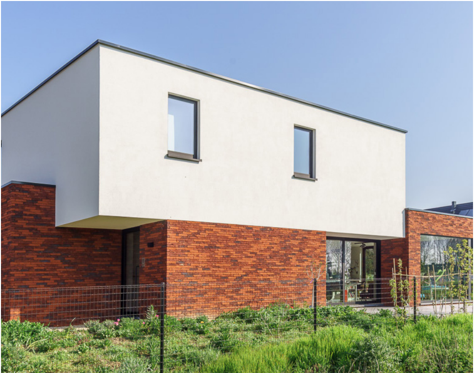
Toepassing plat dag patiowoningen/tweekappers toegestaan; Combinatie tussen roodbruin metselwerk en witte gevelmaterialisatie
