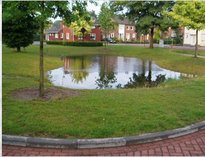
Fig. 3.1 Wadi's bieden ruimte voor waterberging
