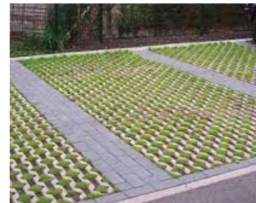
Fig. 3.14 Groen (klimaatadaptief) parkeren: grasbetontegels voor haaks- en langsparkeren
