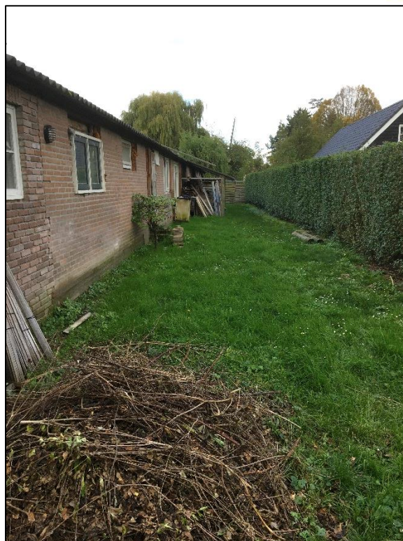
Foto 2. De oostzijde van het gebouw
