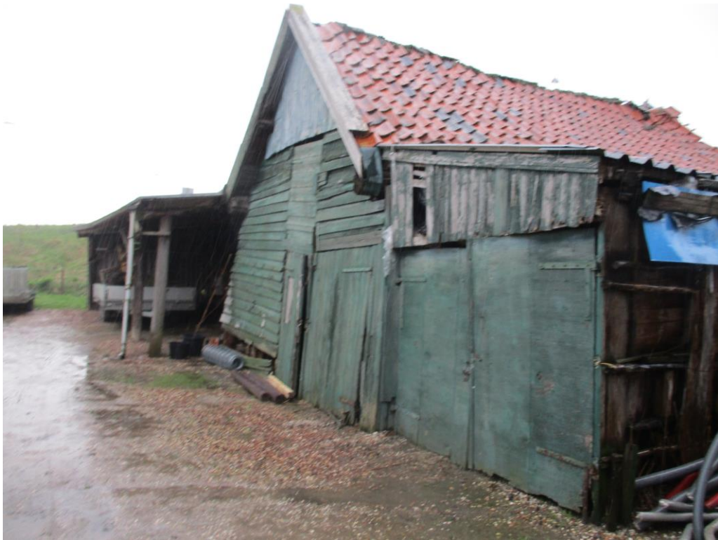
Figuur 1 De schuur met overkapping (C en D) is in een erbarmelijke staat en heeft een pannen en damwandplaten dak zonder dakbeshot.
