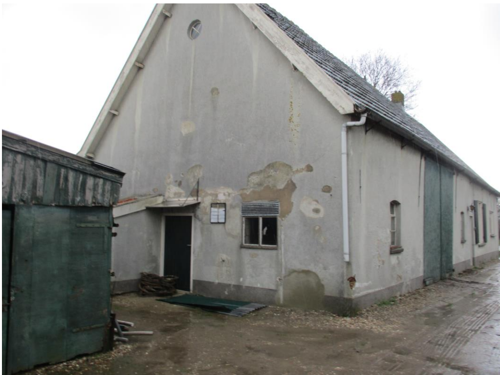
Figuur 2 De woning (A) heeft aan de westzijde een oude stalruimte met een rietendak zonder dakbeshot en aan de oostzijde een woonruimte met een dakbeshot.
