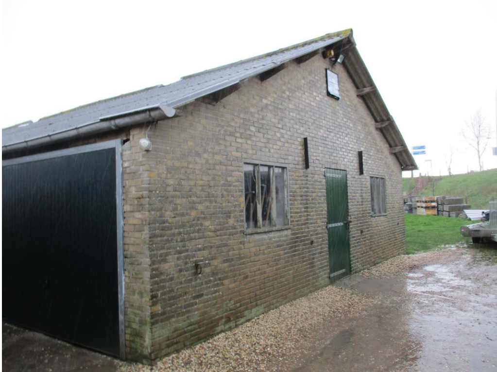
Figuur 3 De schuur (C) is ontoegankelijk doordat het dak direct aansluit op de stenenmuren en overige openingen zijn afgesloten met platen.
