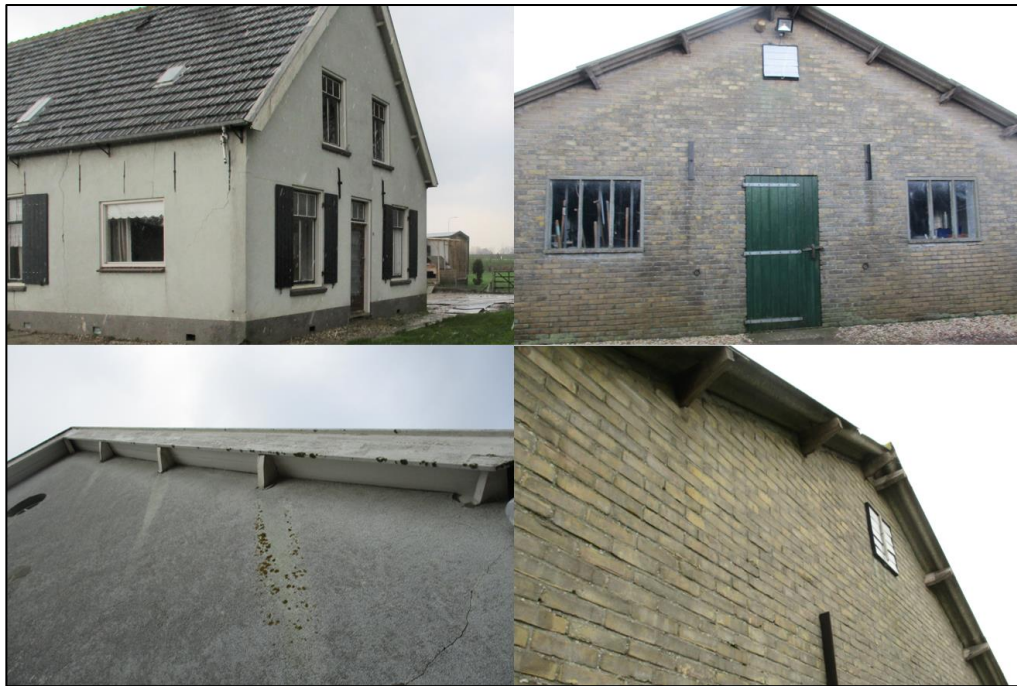
Figuur 3 De woning, met behoudens van de noordzijde, de stallen, schuren en tijdelijke woningen hebben geen geschikte in- en uitlopiegopening welke leiden naar een mogelijk geschikte rust- en verblijfplaats voor vleermuizen.
