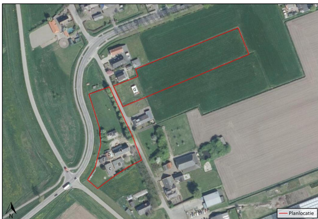
Figuur 1 De planlocatie (rood omkaderd) is gelegen aan de Slijkwellsestraat 3 te Well (bron kaartmateriaal: arcgis.com).
