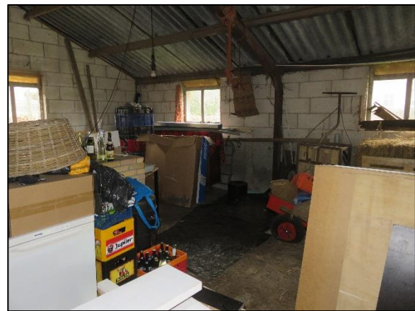
Foto 4. Binnen in de schuur
