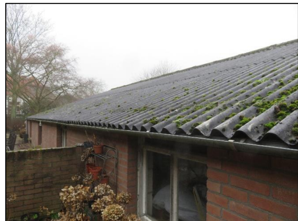
Foto 6. Dak en zijmuur van de schuur
