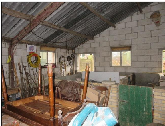
Foto 3. Binnen in de schuur
