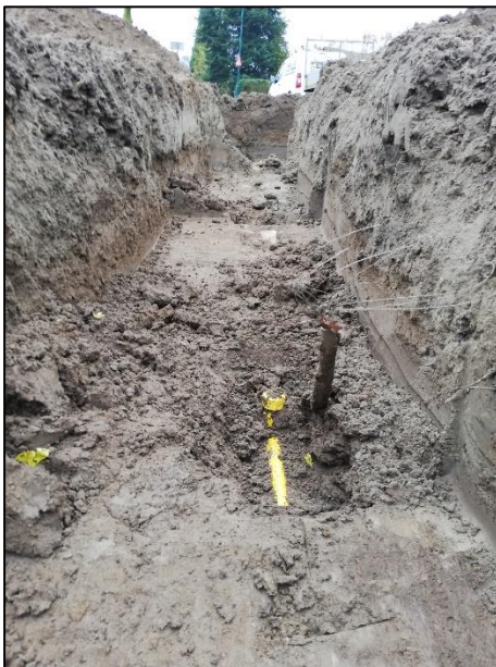
Afb.5 – Laagsgewijs ontgraven
