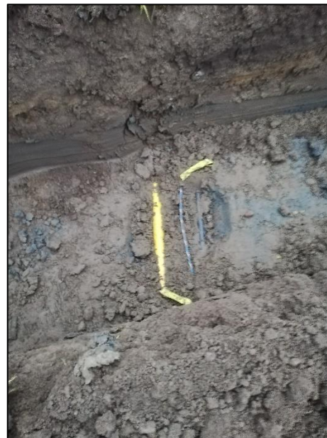
Afb.6 – Aangetroffen gasleiding in opsporingsgebied
