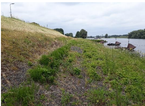
Bokhovense Maasdijk in deelgebied drie
