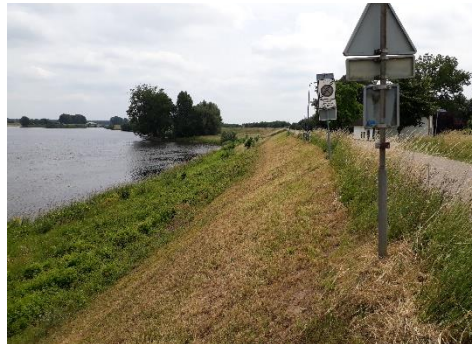
Bokhovense Maasdijk in deelgebied drie
