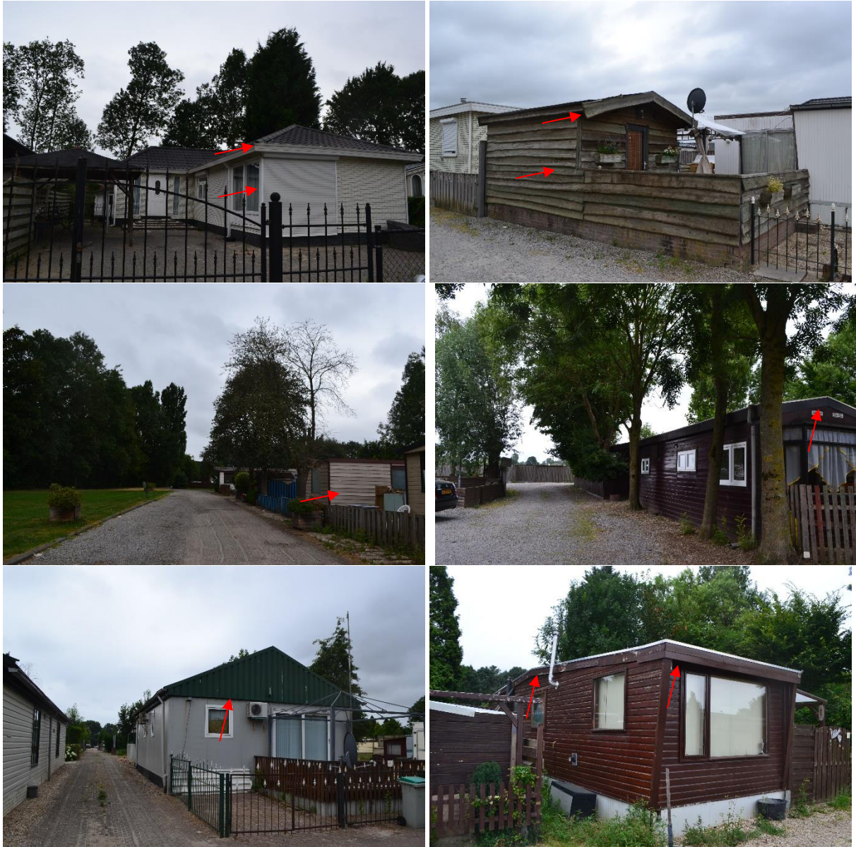
Figuur 3.2: Voorbeelden van een aantal accommodaties geschikt als rust- of voortplantingslocatie vleermuizen. Ter plaatse van de rode pijlen zijn openingen aanwezig waar vleermuizen achter kunnen kruipen.
