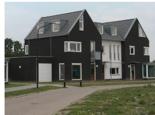
Onderscheid binnen een rij door kleurgebruik, kapvorm, gevelindeling en een verspringsing in de rooilijn
