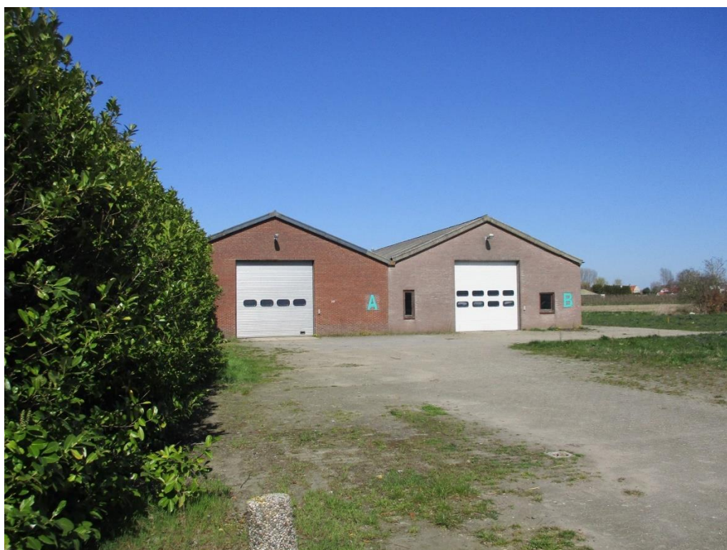
Figuur 2 Binnen de planlocatie zijn twee te slopen opstallen aanwezig. Deze opstallen zijn ongeschikt voor beschermde soorten.
