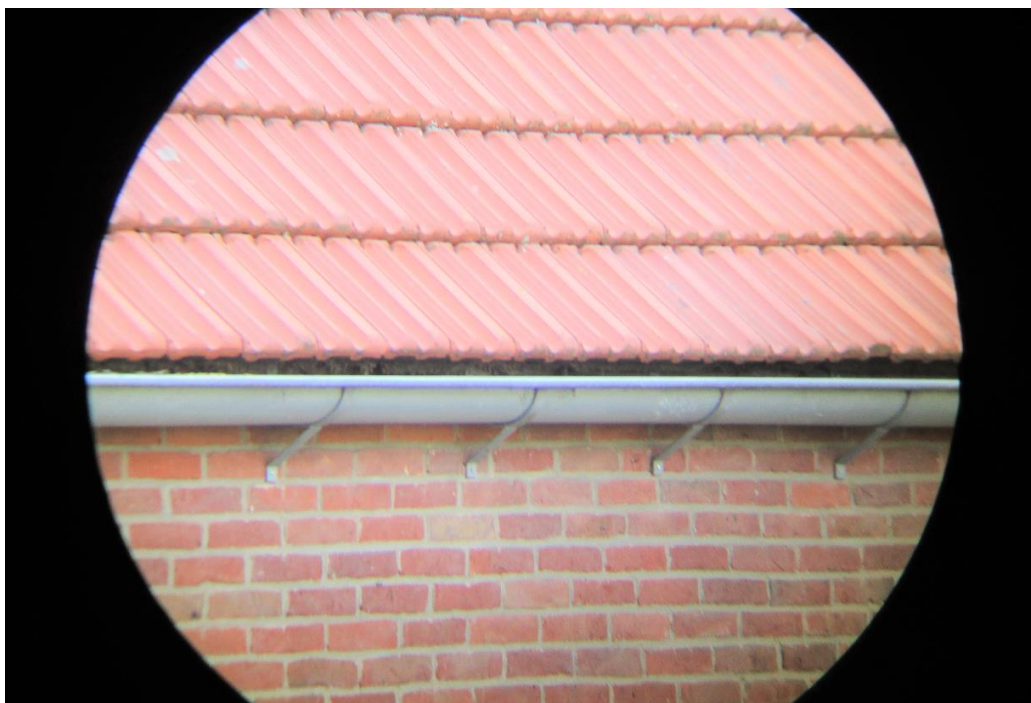
Figuur 3 De woning aan de Hoorzik 14 lijkt geschikt voor nestlocaties van huismussen. Er lijkt een houten betimmering aanwezig te zijn onder de dakpannen, maar het is niet goed zichtbaar of deze betimmering de toegang voor huismussen geheel verspert.
