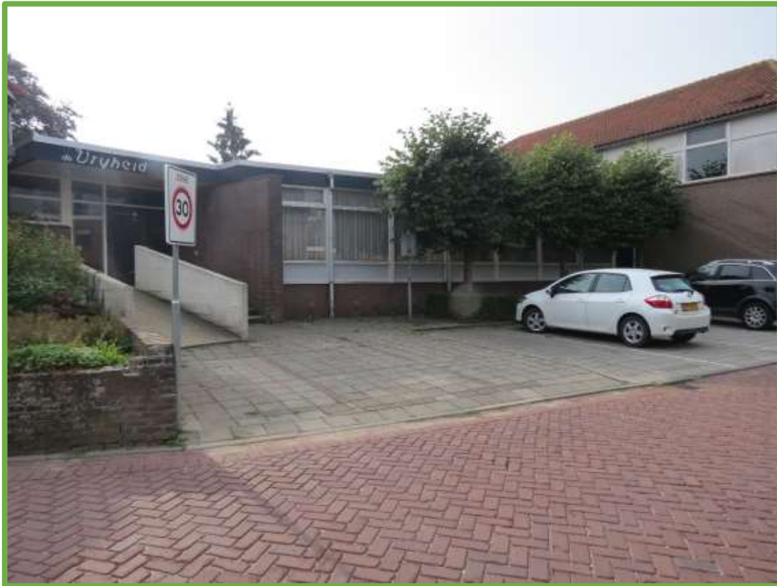
Midden/ tussenstuk hoek Oude Maasdijk (wordt gesloopt)
