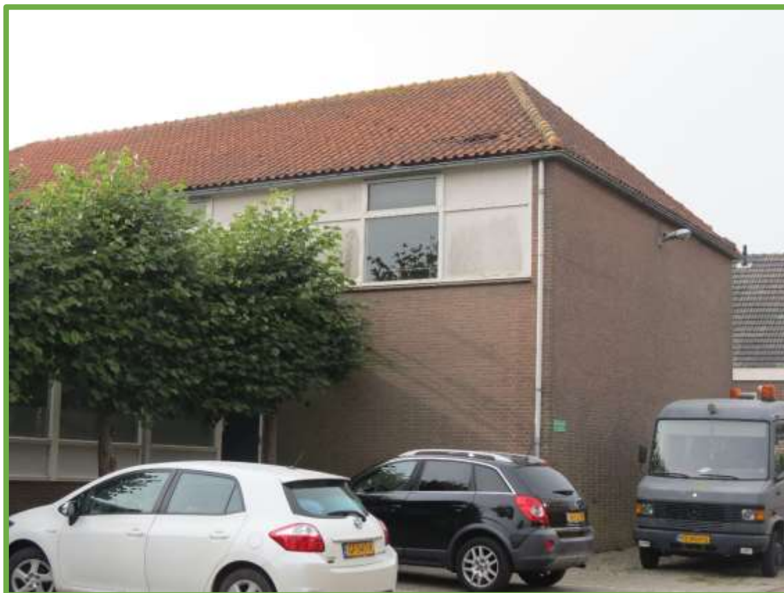
Gymzaal (wordt gesloopt)
