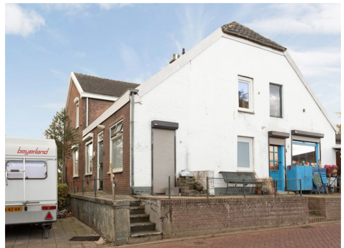
Bestaande boerderij met achterzijde naar openbare weg
