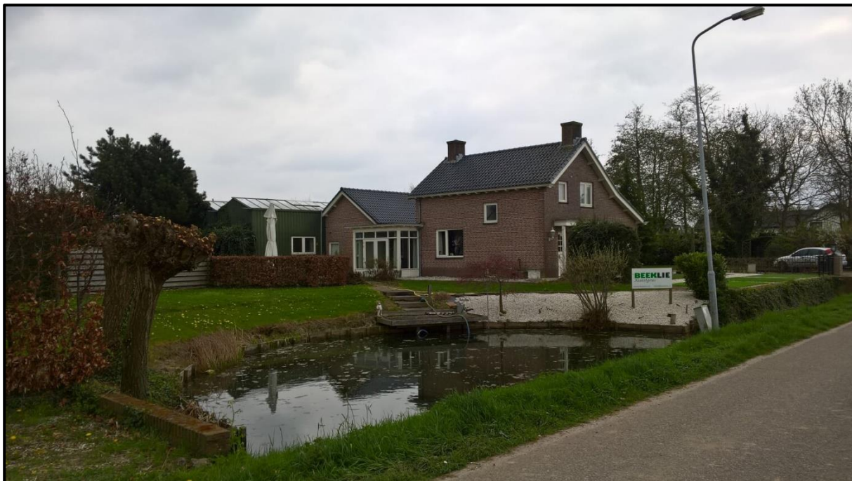
Aanzicht huidige bedrijfswoning Bussenerweg 1A.
