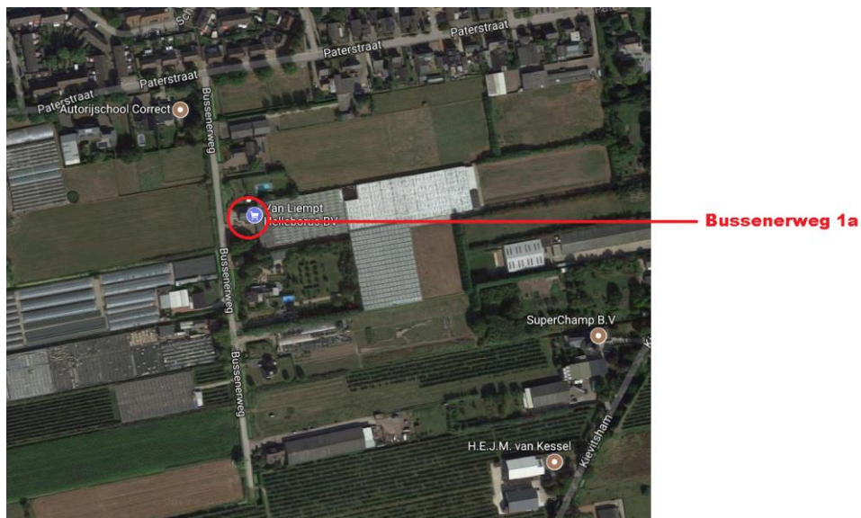
Figuur 1. Pand aan de Bussenerweg 1a te Kerkdriel
