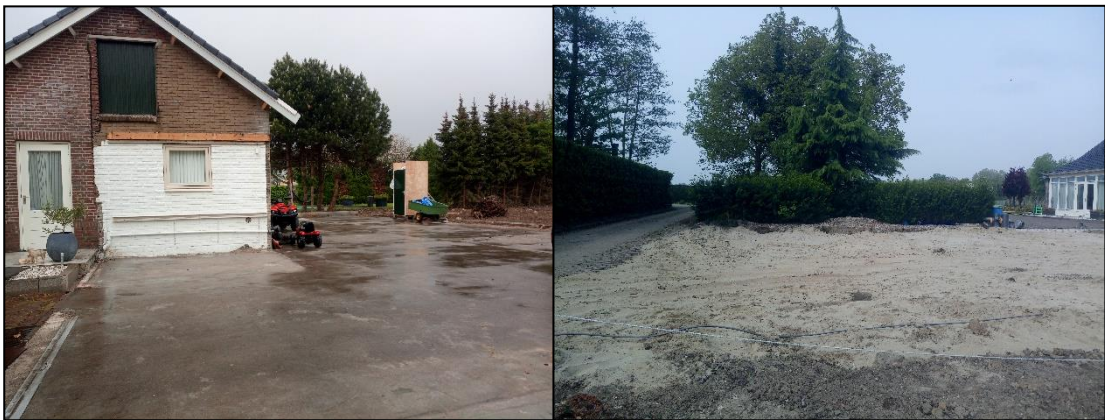
Figuur 3: Foto's van het plangebied ten tijde van het veldonderzoek (02-05-2019 t/m 03-05-2019). Links: De bestaande bebouwing gezien vanuit het zuiden. Rechts: Het plangebied gezien vanaf het oosten.
