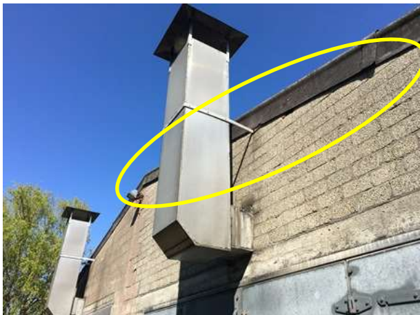
Potentiële verblijfplaats van gebouwbewonende vleermuizen, zoals gewone dwergvleermuis. Deze wordt niet benut door vleermuizen.
