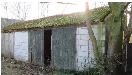
Foto 7. Noordzijde van de te slopen schuur
