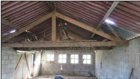
Foto 3. Binnenkant van de te slopen schuur
