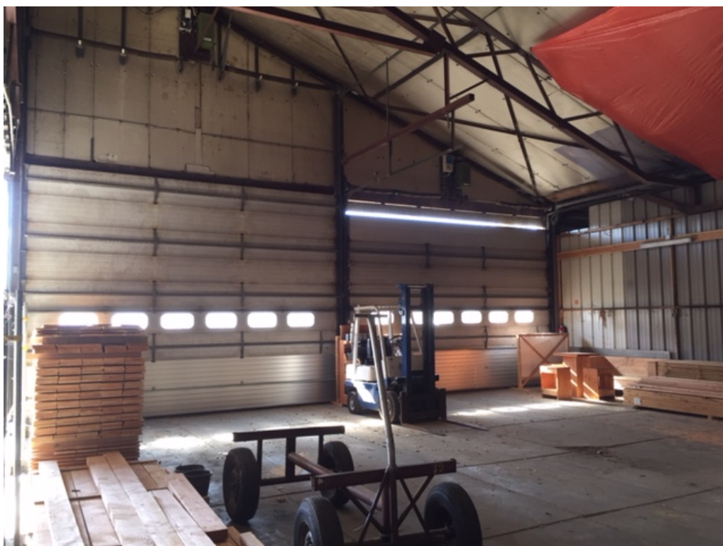
Figuur 2 Een gedeelte van de aardappelschuur staat leeg, enkele ander delen worden gebruikt als magazijn, opslag van hout, stalling van een vrachtwagen en als opslag van een fruittelersboedel.
