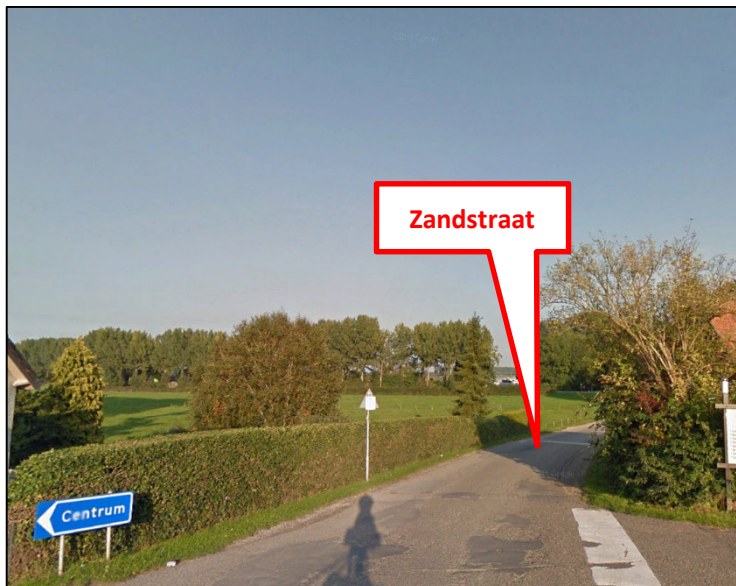
Figuur 4: Wegdek op Zandstraat
