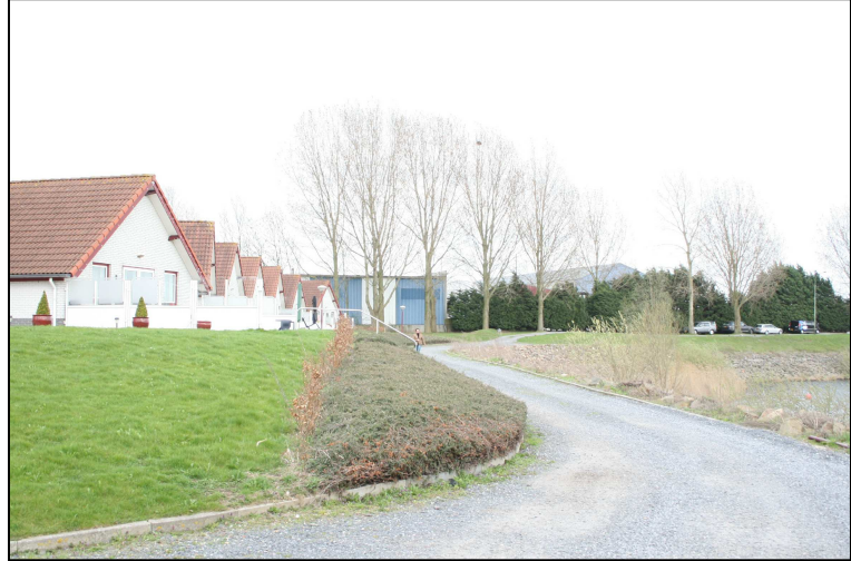
Foto 3 Zicht op bestaande recreatiebungalows halfverharding en talud
