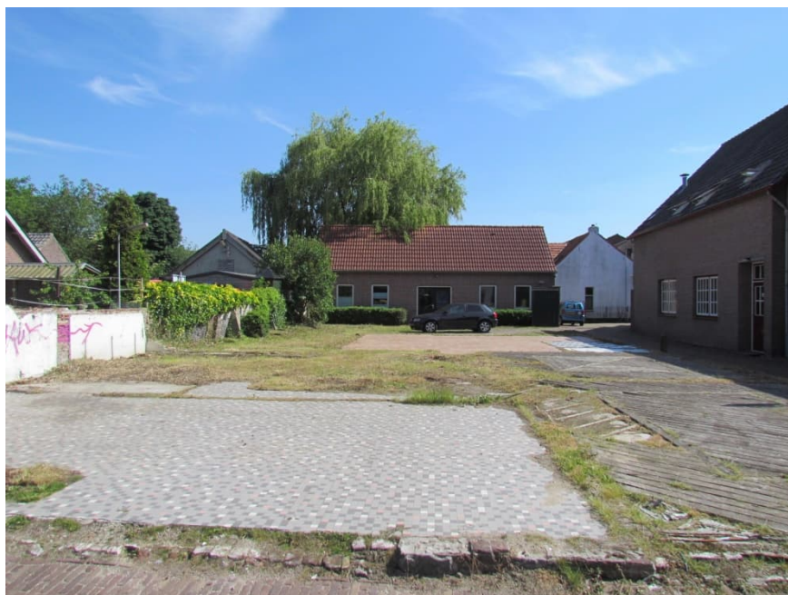
Restanten fundamenteën en bestaande verharding
