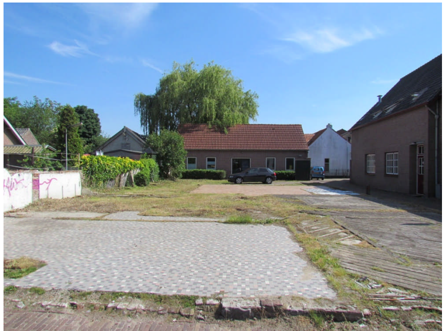
Restanten fundamenteën en bestaande verharding
