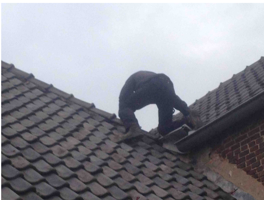
Figuur 2 FaunaConstruct heeft de dakvlakken geïnspecteerd op geschiktheid voor vleermuizen en (broed)vogels.
