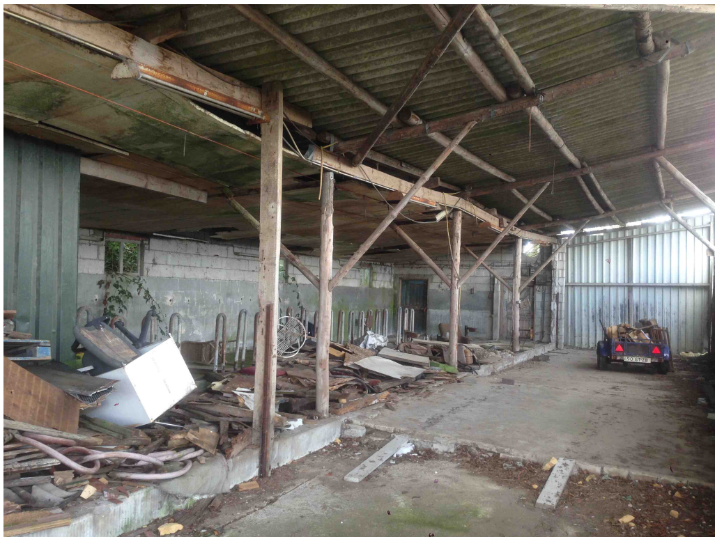
Figuur 4 De kapschuur heeft een zeer openstructuur en is derhalve ongeschikt voor vleermuizen.
