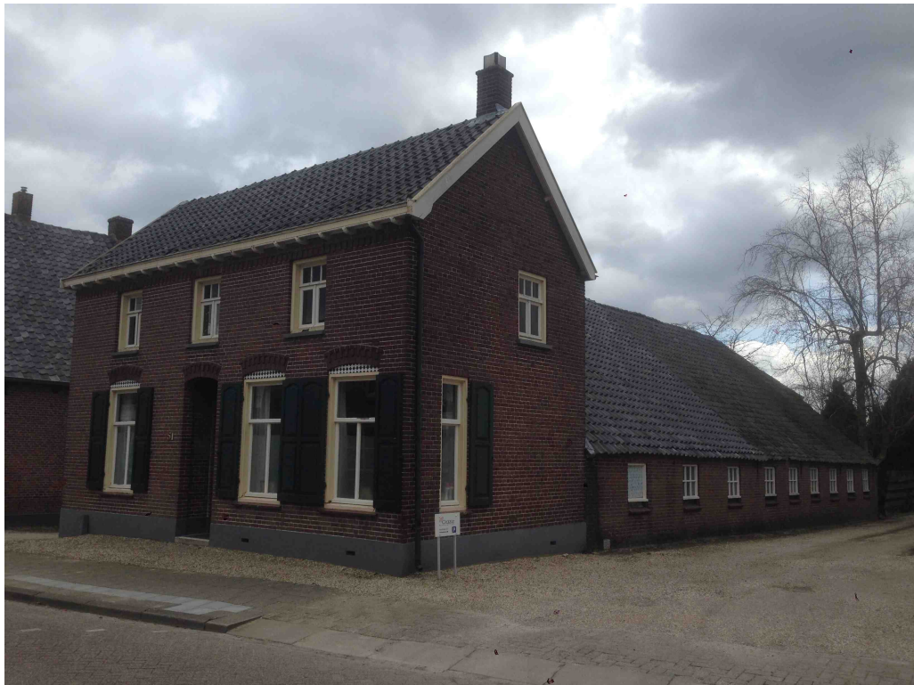
Figuur 3 Ten behoeve van de ontsluiting wordt de woning en kapschuur aan de Voorstraat 51 gesloopt.
