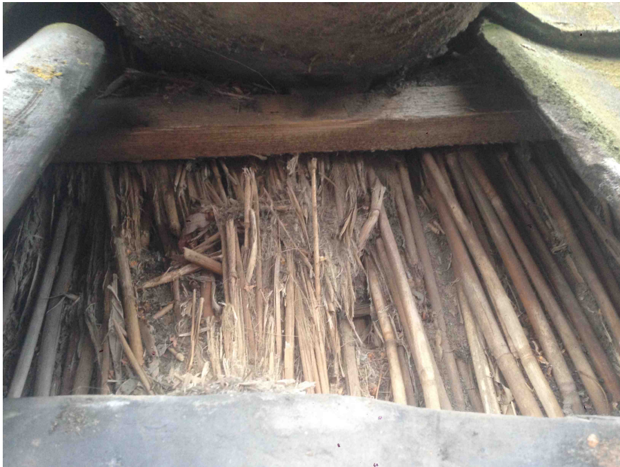
Figuur 1 Het dak van het achterhuis bestaat uit riet met pannen
