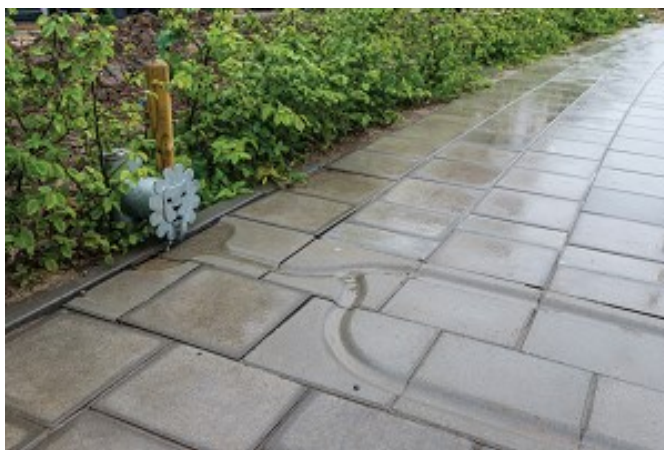
Figuur 9 Spuer met watertegels in trottoir
