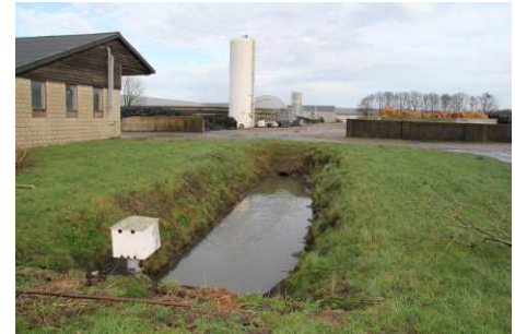
Figuur 4. Westzijde terrein met afwatering.
