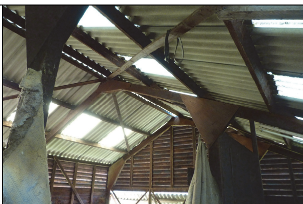
Foto 2. Binnenzijde westelijke deel schuur
