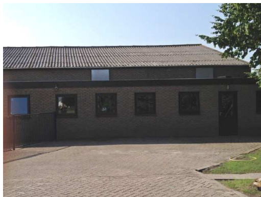
Figuur 3. Voorzijde bedrijfsgebouw met op de voorgrond het kantoor.
